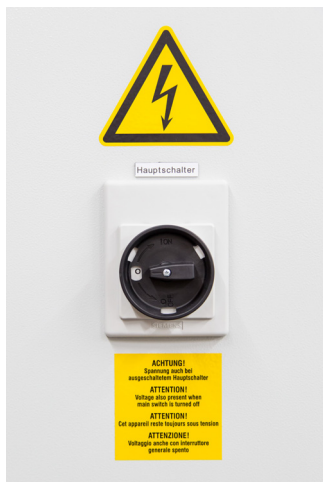
Abbildung 1: Hauptschalter Schaltschranktüre
